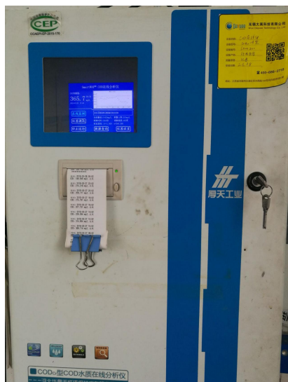
废水排口在线监控
