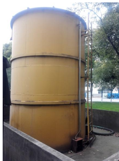
储罐围堰情况
